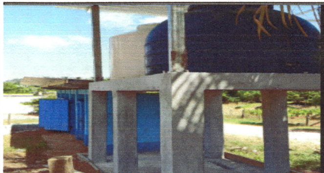
Foto 3: SE CONSTRUYÓ LAS BASES DEL ENTRARIMADO DE LOS DOS TINACOS PARA ABASTECER DE AGUA LOS BAÑOS SANITARIOS.
