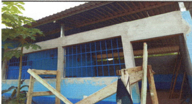
Foto 2: SE CAMBIARON LAS TELAS DE MALLAS A BALCONES DE METAL.
