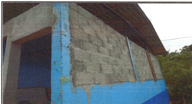
Foto 4: SE REMODELÓ UNA DE LAS AULAS QUE NO ESTABA TERMINADO DE SUS PAREDES EN LOS TRES LADOS.
