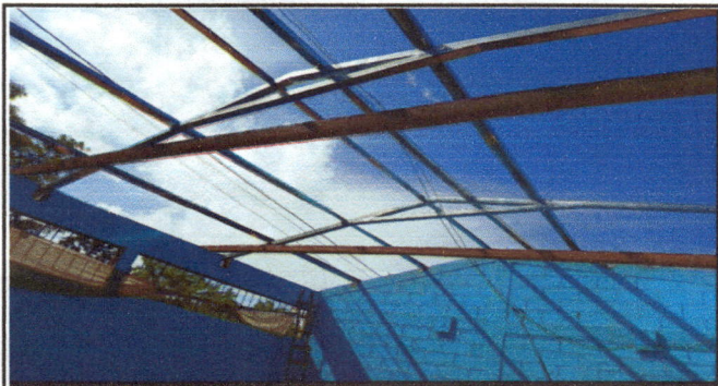
Foto 1: SE CAMBIARON LAS COSTANERAS DE MADERA A METAL PARA EL ENTECHADO.
